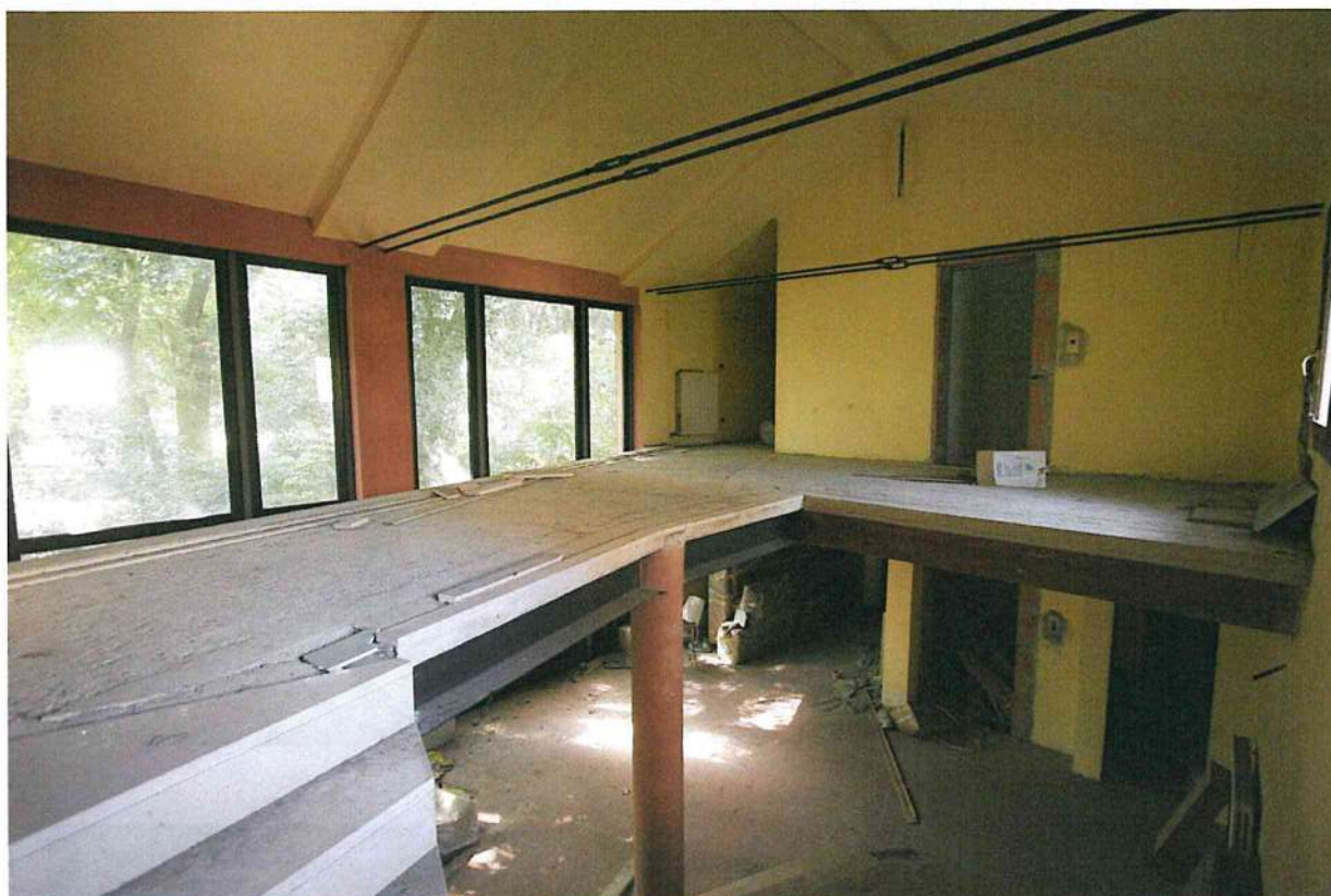
Immagine n. 20 - Vista interna atrio Barchesse dal piano primo
