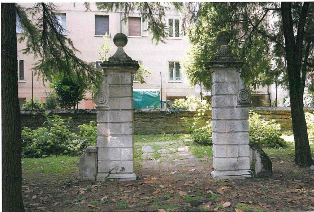
Immagine n. 14 - Portale alla fine del giardino in corrispondenza con l'accesso alla Seriola
